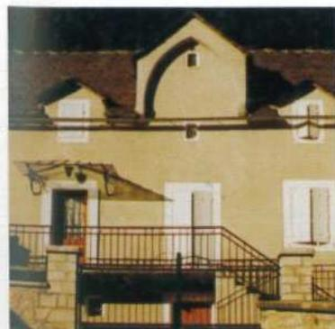
1-Toiture en lauzes de schiste ou ardoise Pente 80% à 100%
