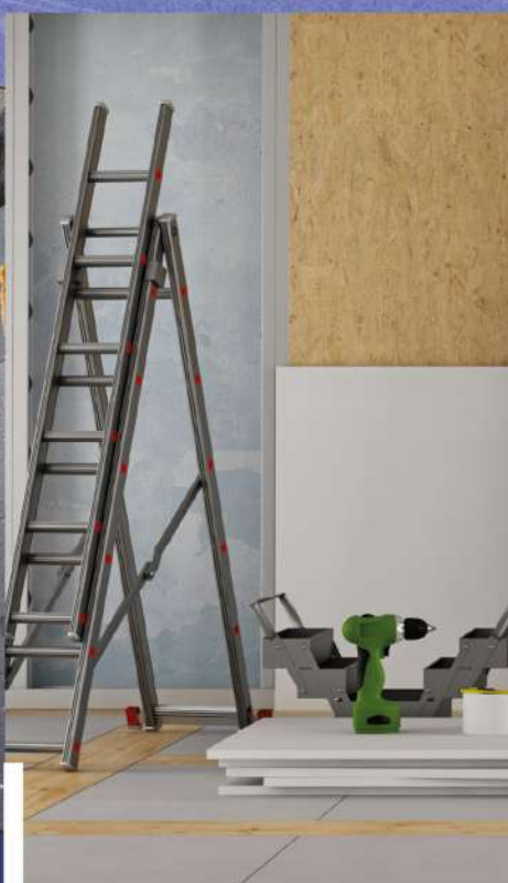
REMISE EN ÉTAT D'UN LOGEMENT DÉGRADÉ
